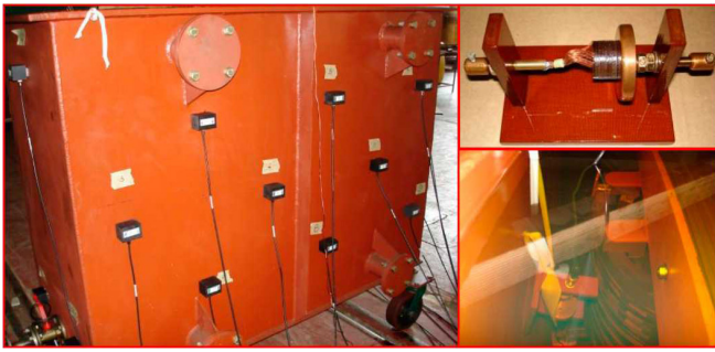
Рис. 7. Установка датчика (слева), источник ЧР (справа сверху) и его установка на бак (справа снизу)
